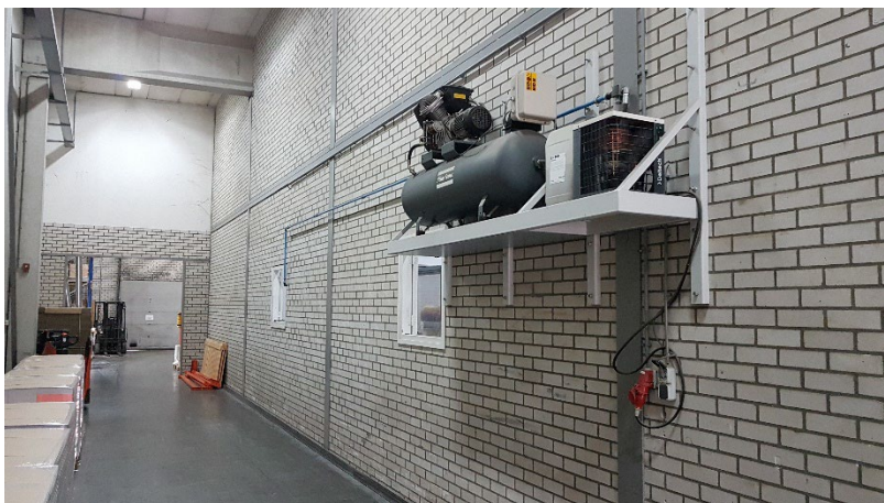
Voorbeeld van een compressor die van de productieruimte verplaatst is naar een zijgang
